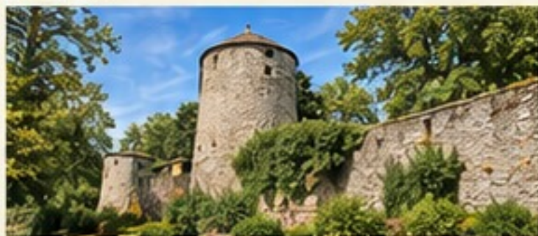
Une tour des remparts encore visible
